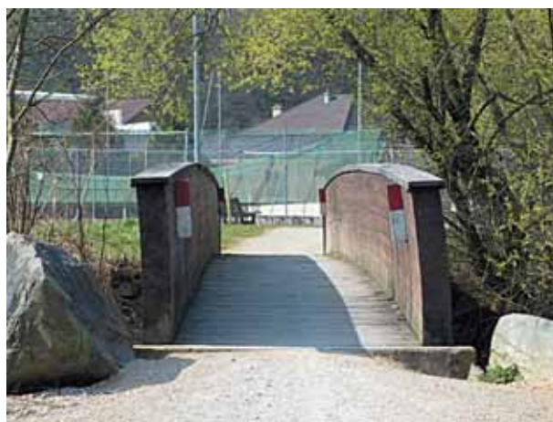
Figure 61 - Déformations latérales de poutres en bois lamellé collé.
