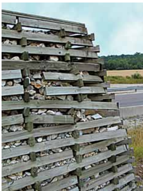
Figure 22 - Désorganisation d'un mur de soutènement
