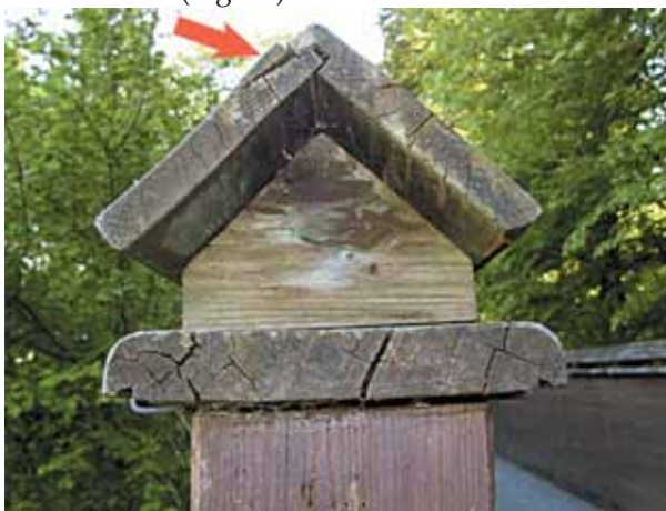
Figure 45 - Assemblage bois sur bois piégeant l'eau.
