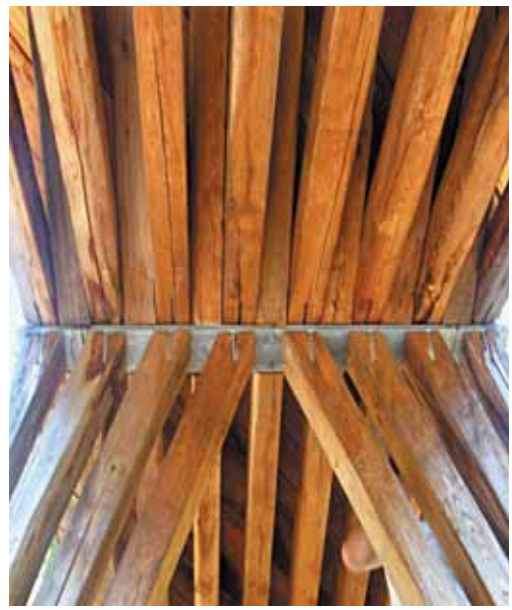
Figure 16 - Bois fendu sous chaussée.
