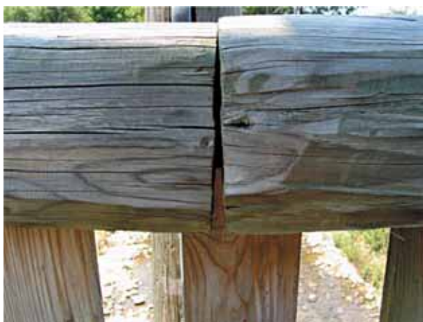
Figure 63 - Désalignement de lisses d'une main courante.
