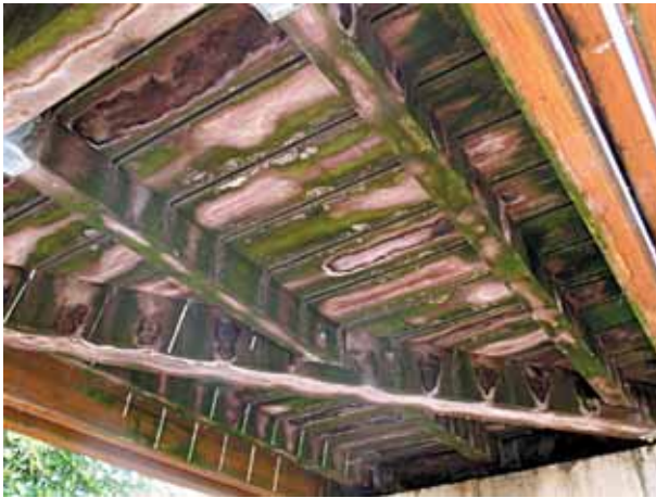
Figure 54 - Zones sombres témoins d'humidification localement élevée. La mousse verte est un lichen.
