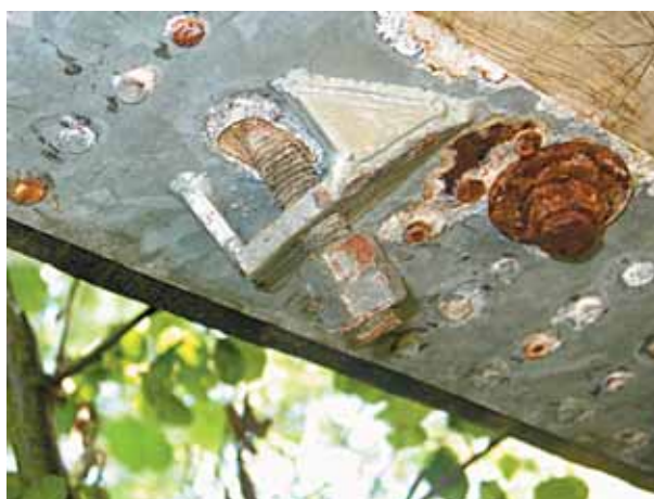
Figure 66 - Oxydation d'organes métalliques.
