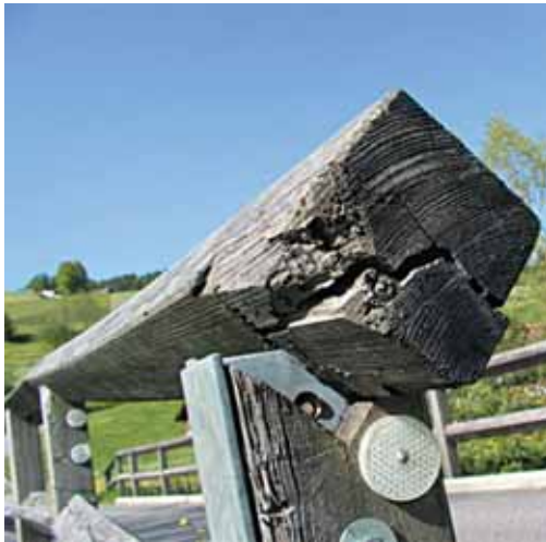
Figure 25 - Attache de la main courante sous-dimensionnée.
