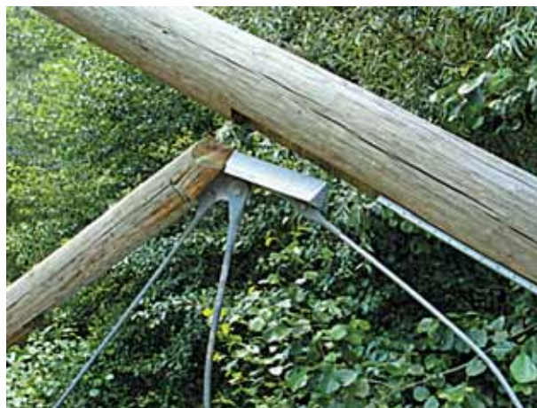
Figure 68 - Rupture d'un assemblage.
