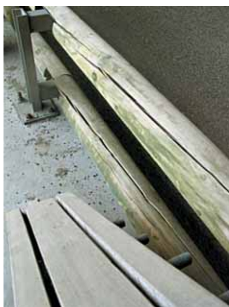
Figure 65 - Fente de retrait sur du bois rond.
