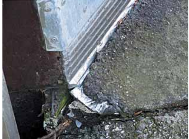
Figure 40 - Liaison poutre tablier et chaussée d'accès.
