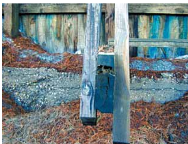
Figure 64 - Rupture par excès de traction transversale.
