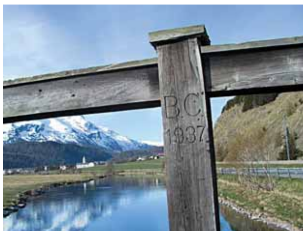
Figure 73 - Grisaillement uniforme.
