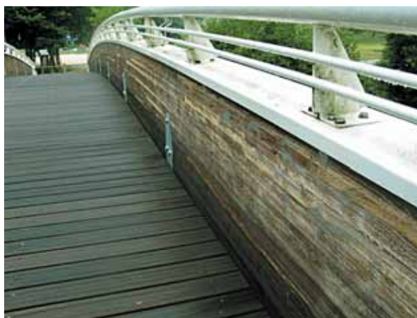
Figure 74 - Dégradation des lasures.
