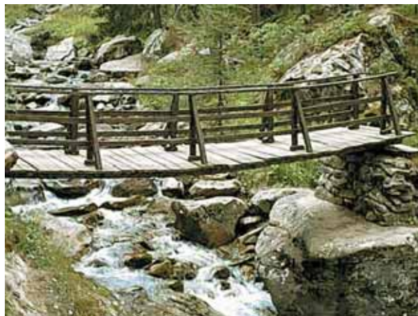
Figure 60 - Passerelle présentant une flèche importante.
