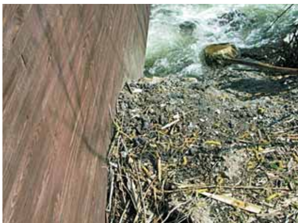
Figure 43 - Accumulation de terre au contact du bois.
