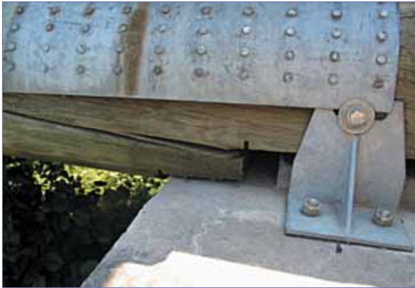
Figure 28 - Rupture du bois par traction transversale.
