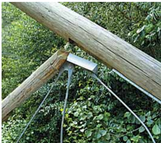
Figure 21 - Rupture d'un assemblage.
