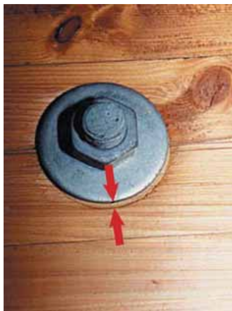
Figure 67 - Déplacement d'assemblage.
