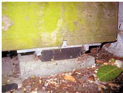
Figure 49 - « Mousse » verte et sèche disparaissant en frottant avec la main.
