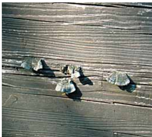
Figure 53 - Champignons apparents témoins de dégradation avancée.
