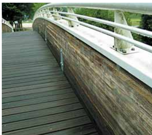
Figure 51 - Dégradation d'une lasure par farinage.
