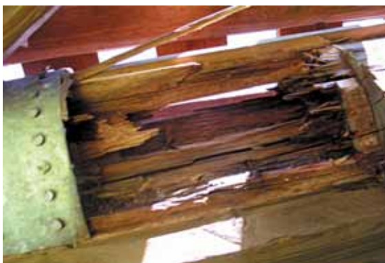
Figure 30 - Rupture du bois par traction (arrachement des fibres).
