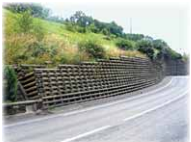
Mur de soutènement
