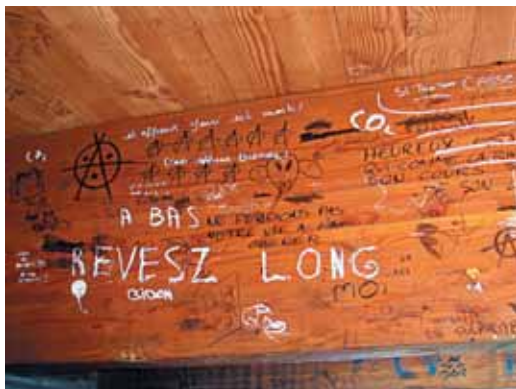
Figure 50 - Vandalisme : Présence de graffitis.
