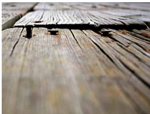
Figure 24 - Déclouement du platelage suite aux vibrations.
