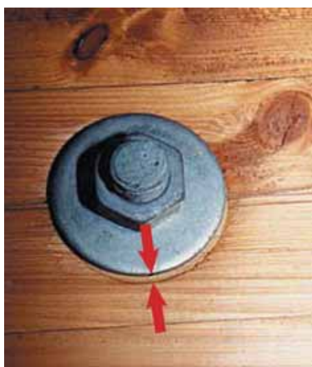
Figure 19 - Déplacement du boulon d'assemblage.
