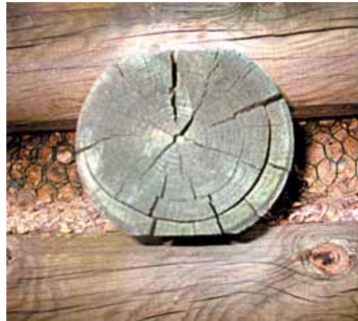
Figure 31 - Surcompression du bois rond et fente due au séchage.
