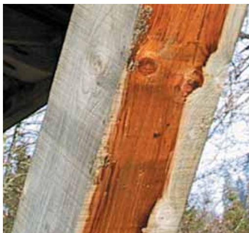
Figure 10 - Exemple de grisaillement du bois.
