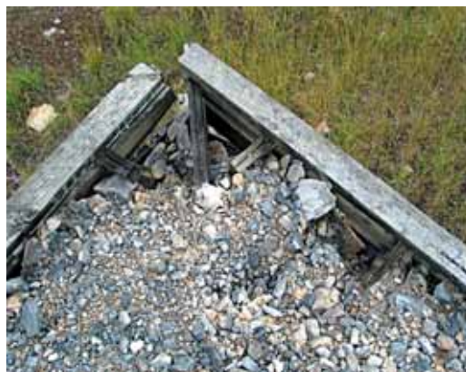
Figure 23 - Mauvaise conception du coin.
