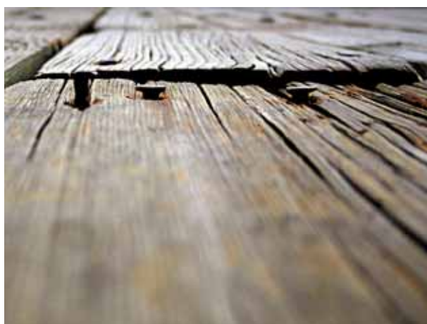
Figure 69 - Déclouement du platelage.
