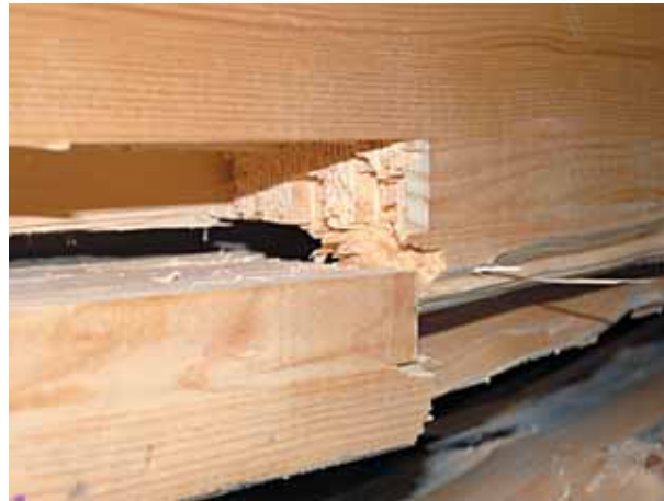
Figure 34 - Rupture complète par perte de section résistante.
